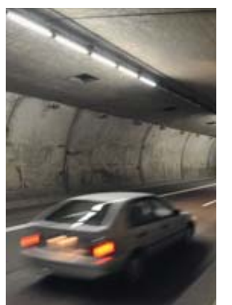
Des panneaux solaires éclaireront le tunnel de la Clusette dès 2025.
